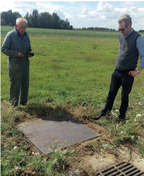
De beschadigde putdeksels langs de baan 17/35 waren volgens DGLV een gevaar voor de vliegveiligheid. De baan werd daarop gesloten. Ondertussen liggen er nieuwe, stalen deksels...
